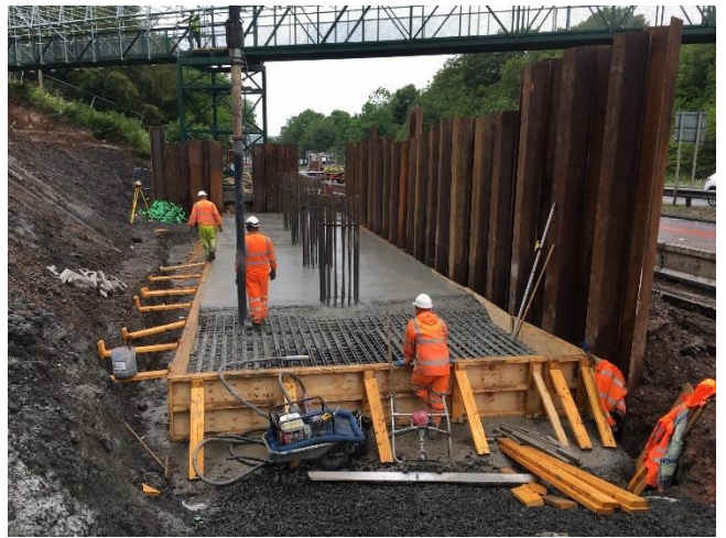
West – Concrete pour in progress
